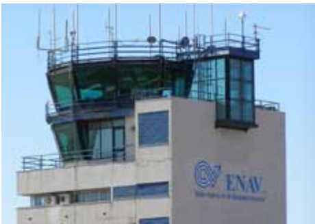
Torre di controllo
